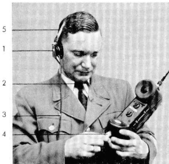
Abb. 6 Tragen der Hörgarnitur und Anschließen des Kabels am Handfunkgerät
