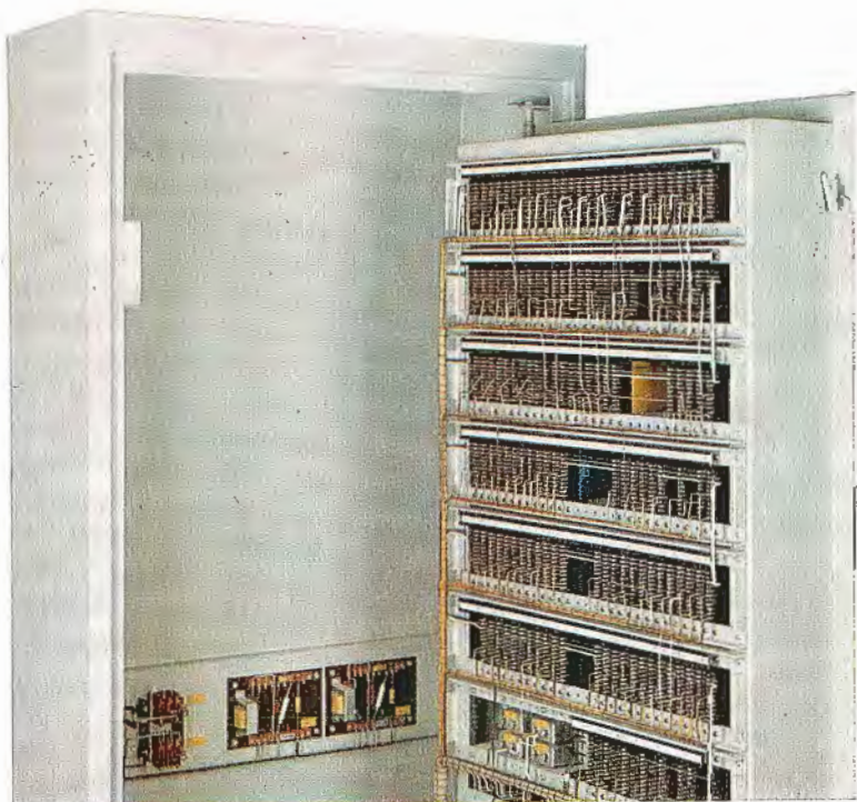
Bild 34 Richtungempfindliche Aufzugsammelsteuerung mit elektrischen Kopierwerk (geöffneter Schwenkrahmen, Vorderansicht siehe Seite 19)
