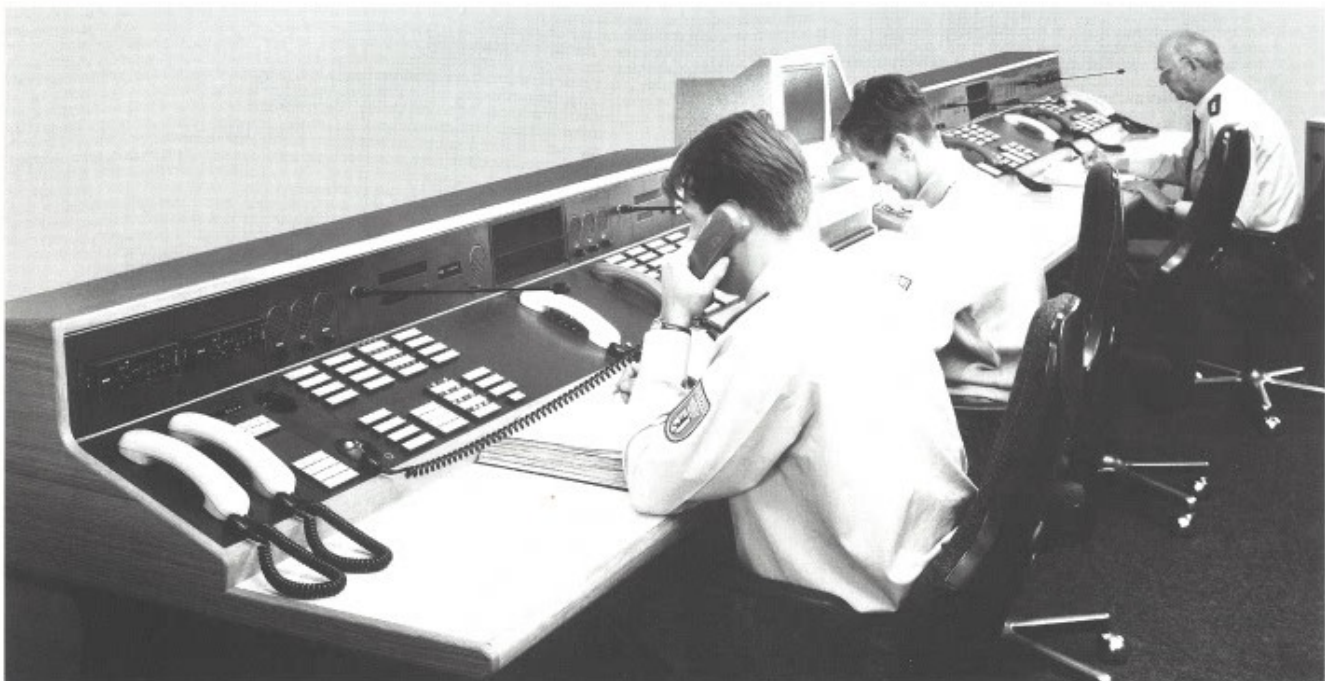
Bild 2: Beispiel eines VMS 256 Bedienplatzes mit vier Disponentenplätzen (Ausführung kundenspezifisch)
